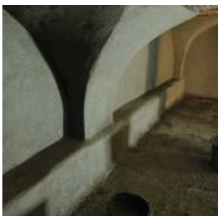
Cemsec - waterdichtingsmortel voor kelder - Predikherenklooster Mechelen
