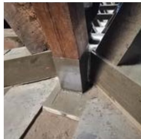
Balkkopherstelling met Artipox HR/RB-2 - Sint Jacobskerk Antwerpen
