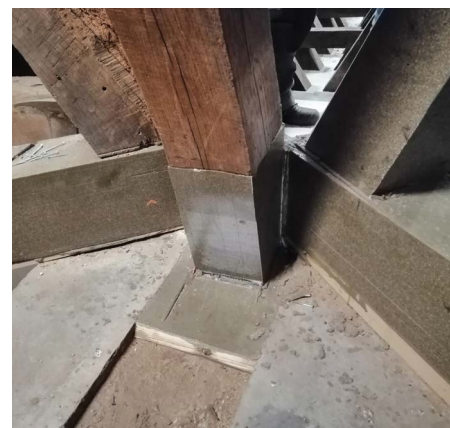
Artipox HR/RB-2 – Mortier pour réparation de têtes de poutres en bois – Eglise Saint Jacques Anvers
