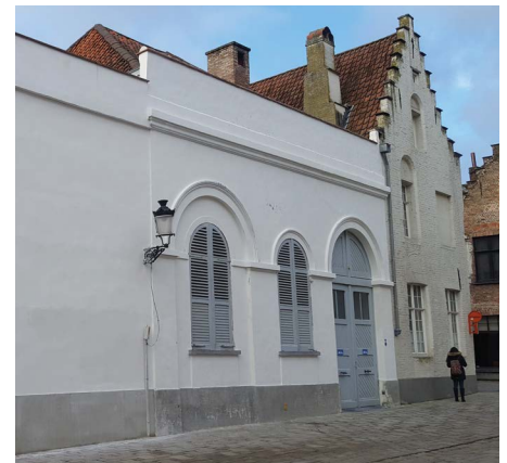
Califinish – Enduit de finition à base de chaux – Façade à Bruges
