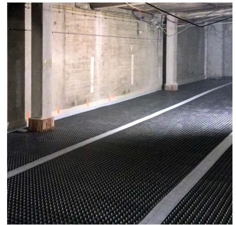
Drain Type 20 membrane à plots et Membrasec Transparent pour blocage des sels – Utilisé dans un parking souterrain
