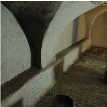
Cemsec - waterdichtingsmortel voor kelder - Predikherenklooster Mechelen
